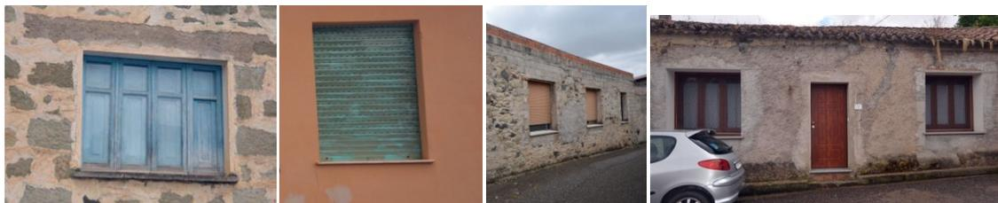
*Anche la riproposizione di falsi architettonici non sempre produce gli effetti desiderati, come l'utilizzo di sistemi di oscuramento e l'accostamento di soluzioni tecniche non compatibili con le forme della tradizione locale .*
