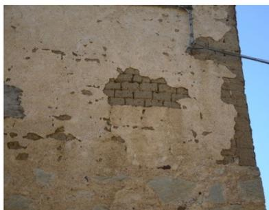
Lo spessore del paramento murario può variare dai 60 ai 80 cm, ma si sono riscontrati anche casi di murature dello spessore di 1 m
