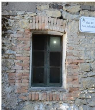
Sono state individuate le seguenti tipologie di serramenti con apertura a due ante e sistema di oscuramento costituito da scurini interni.
