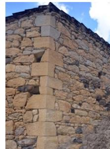
***Muratura con conci grossolanamente sbazzati apparecchiati con allettamento in terra e rinzeppatura secondo corsi sub-orizzontali***
