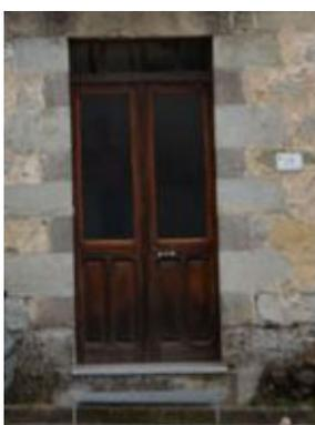
*Di seguito un esempio di criticità generata dall'inserimento e modifica di forature non rispettose dei rapporti storicamente rilevati nei centri storici dell'area in esame. Solitamente la forma quadrata è auspicabile per finestre di piccola dimensione solitamente disposte in corrispondenza di piani mansardati o soppalcati.*
