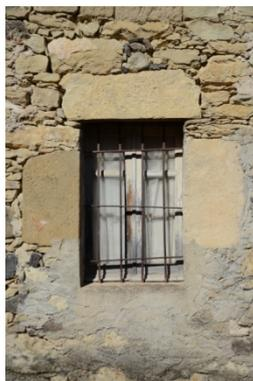
**Finestra con stipiti realizzati in trovanti lapidei e architrave ligneo. Con o senza cornice realizzata con intonaco in rilievo. Forature di dimensioni minime**
